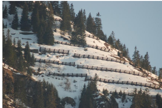
Lawinenverbauungen am Stanserhorn
